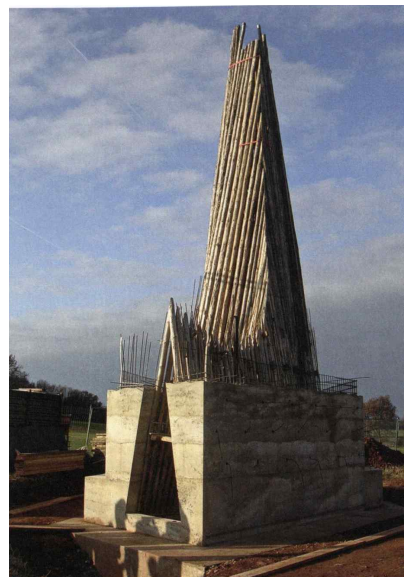
[그림 4-72] 원주목 구조와 콘크리트 타설
